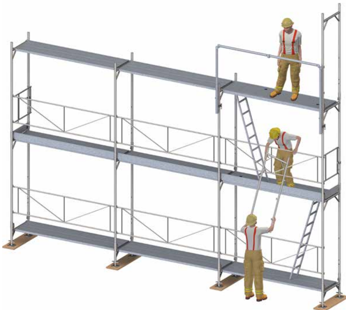
Bild 13: Beispiel für die Materialannahme und Gerüstmontage auf der obersten Gerüstlage.
