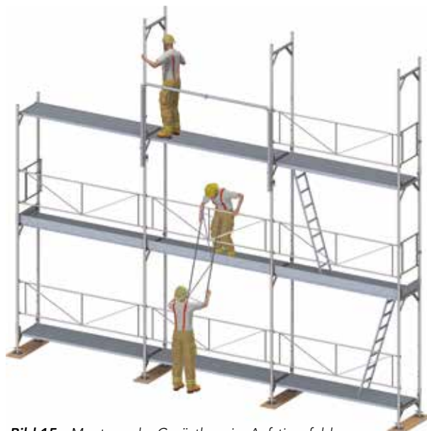
Bild 15: Montage der Gerüstlage im Aufstiegsfeld im Schutze des MSG.
