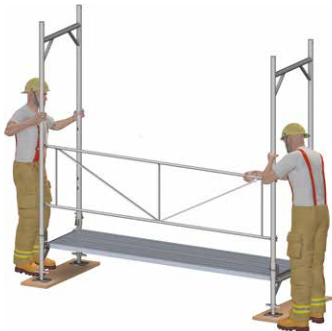
Bild 3: Aufbau des ersten Gerüstfelds.
