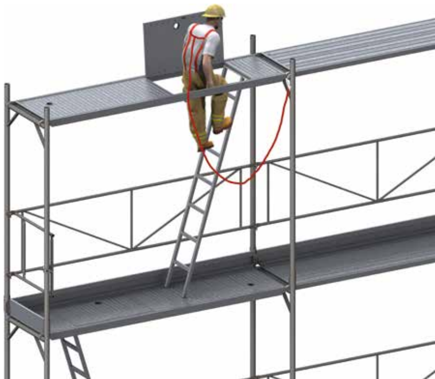
Bild 22: Sicherung mit der PSAgA vor dem Betreten der obersten Gerüstlage.
